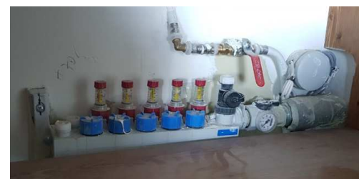
Vannes de régulation installées dans les classes
